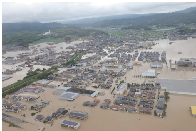
「平成30年7月豪雨」による洪水被害 岡山県倉敷市真備町（東京消防庁提供）
